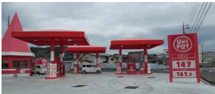
うちこ第一SS／ソーラー発電所
